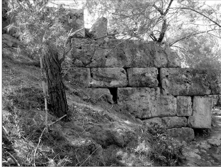
Resim 2: Balıcaoluk Kalesi, doğu duvar
